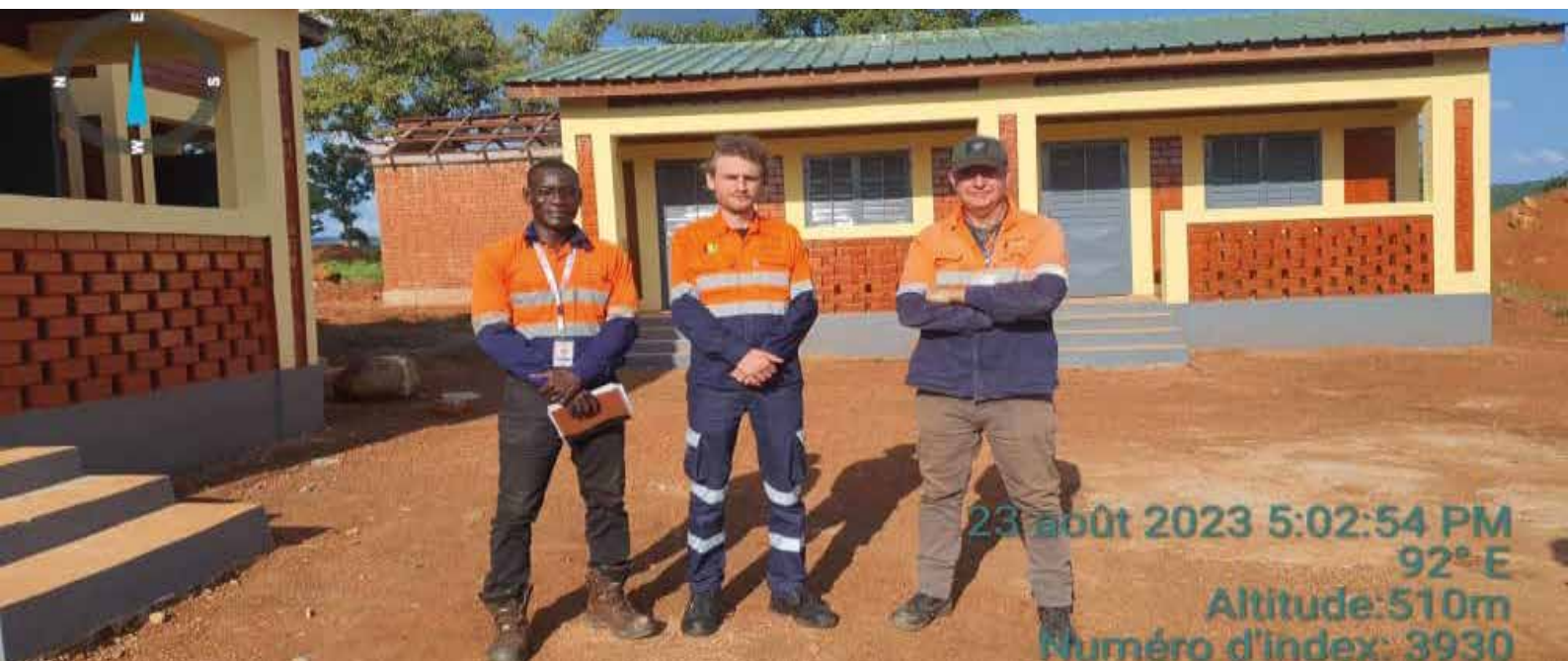
Chantier de réinstallation du village « carrefour »
