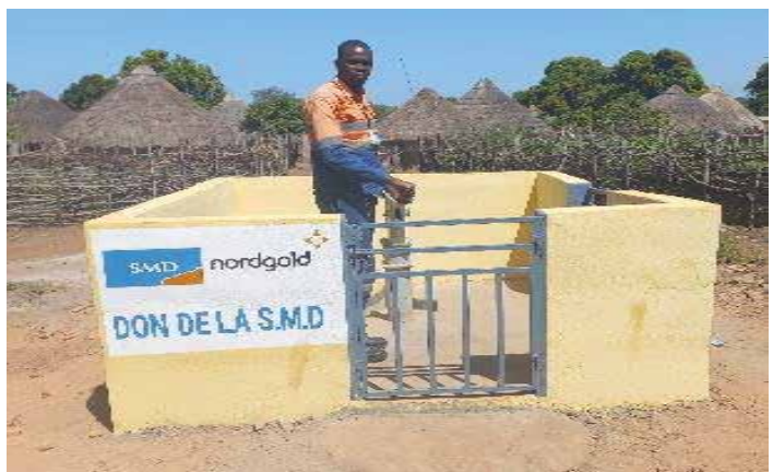
Forage d'eau à Bougoulan
